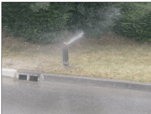
Collecte des eaux pluviales + asperseurs
