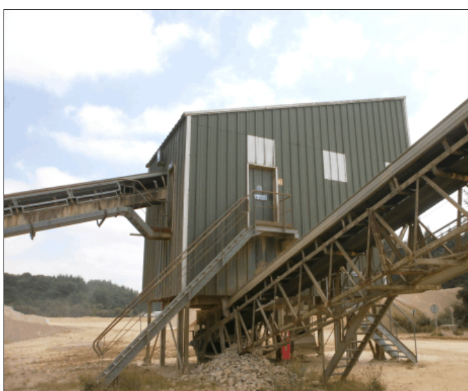
Bardage de l'installation de traitement et bandes transporteuses capotées
