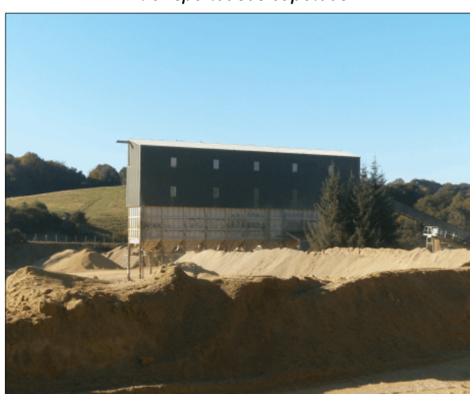
Bardage de l'installation de traitement
