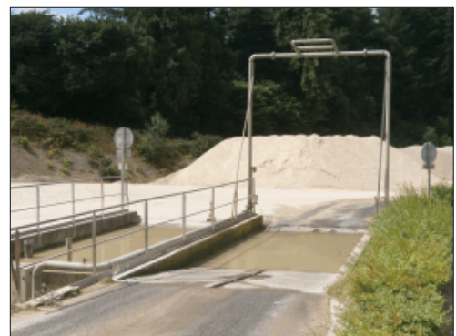
Rampe d'aspersion + laveur de roues en sortie de site
