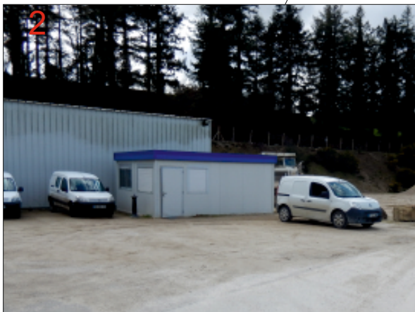
Vue sur l'atelier et les vestiaires
