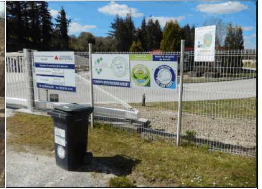
Portail à l'entrée et clôtures périphériques
