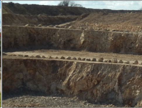
Blocs rocheux le long des pistes de circulation
